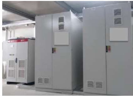
Figura 68. Batterie Sodio-Nichel nel laboratorio PrInCE
